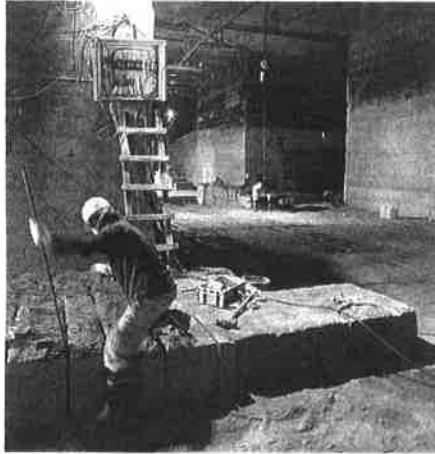
地下作業場では1日20トンの大谷石が採掘される
